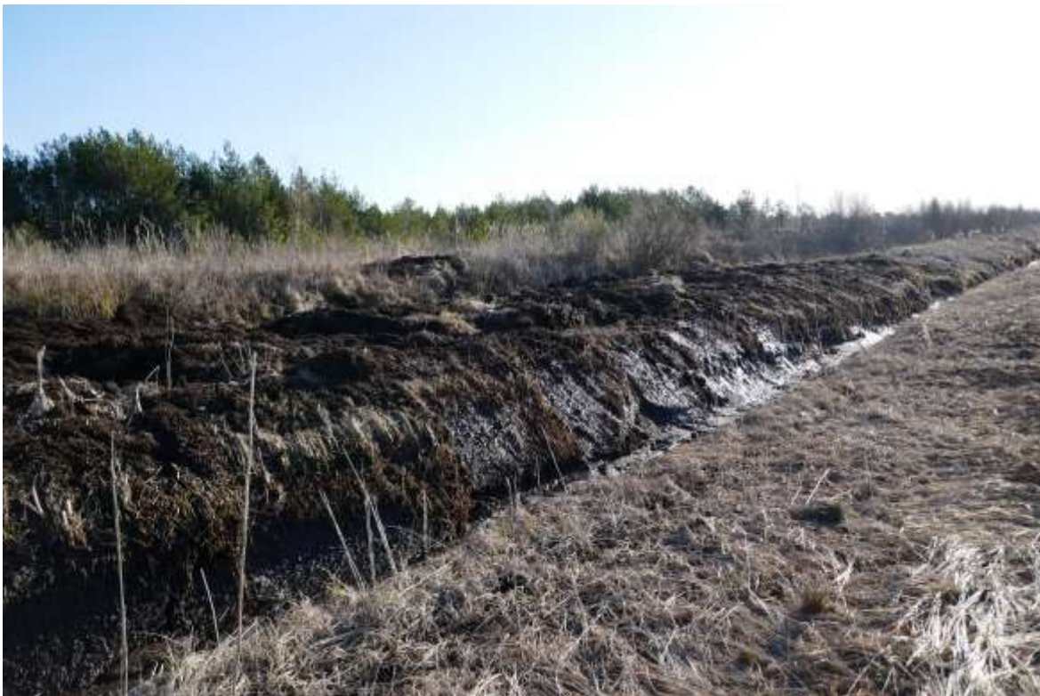
Foto 5. Lavassaare kaevandusala loodeserva rajatud turbast veetõke lasi mitmelt poolt vett läbi ja vajab oluliselt kvaliteetsemat ehitust.
